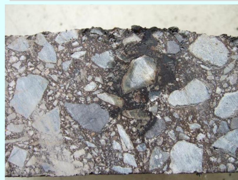
ひび割れへの充填状況
