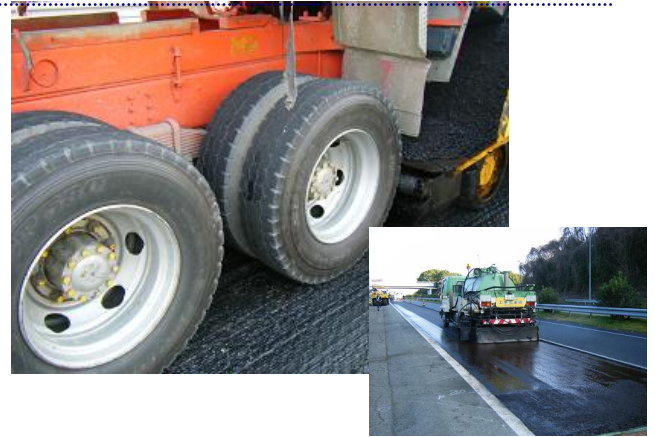
乳剤のタイヤへの付着と散布状況
