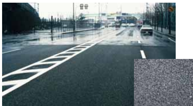
写真.雨天時の排水性舗装(手前)と密粒舗装(後方)の比較
