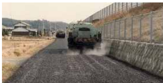
シールコート現場施工状況
