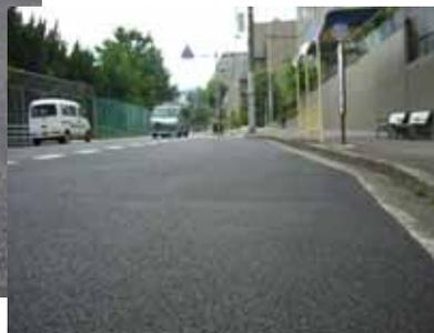
写真-3. 施工現場の路面状況(排水性(13))
