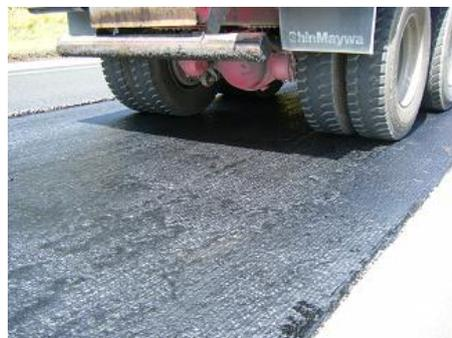
写真-1 タイヤへの付着低減状況
