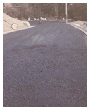
散布現場状況
