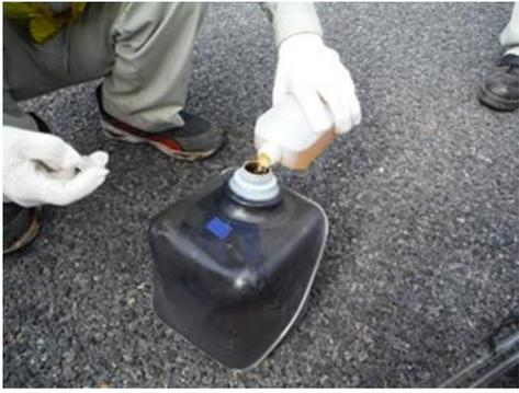
主剤容器に、材料温度に応じた硬化遅延剤を投入・混合後、硬化剤を投入・混合する
