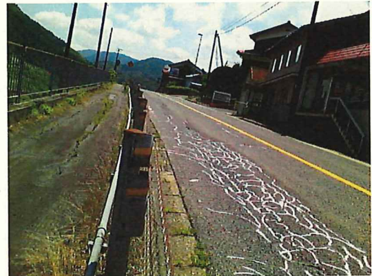
図-3 国道9号線路面状況
