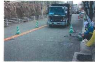
写真-2 輪荷重によるたわみ計測状況
