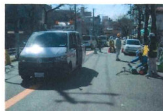
写真-1 OCMによるたわみ計測状況
