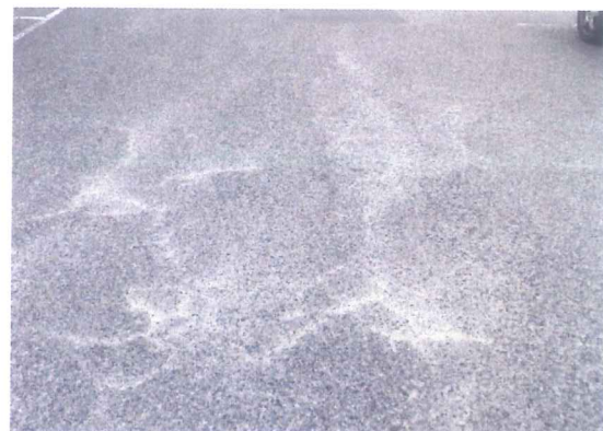
図-1 ポンピング現象の例
